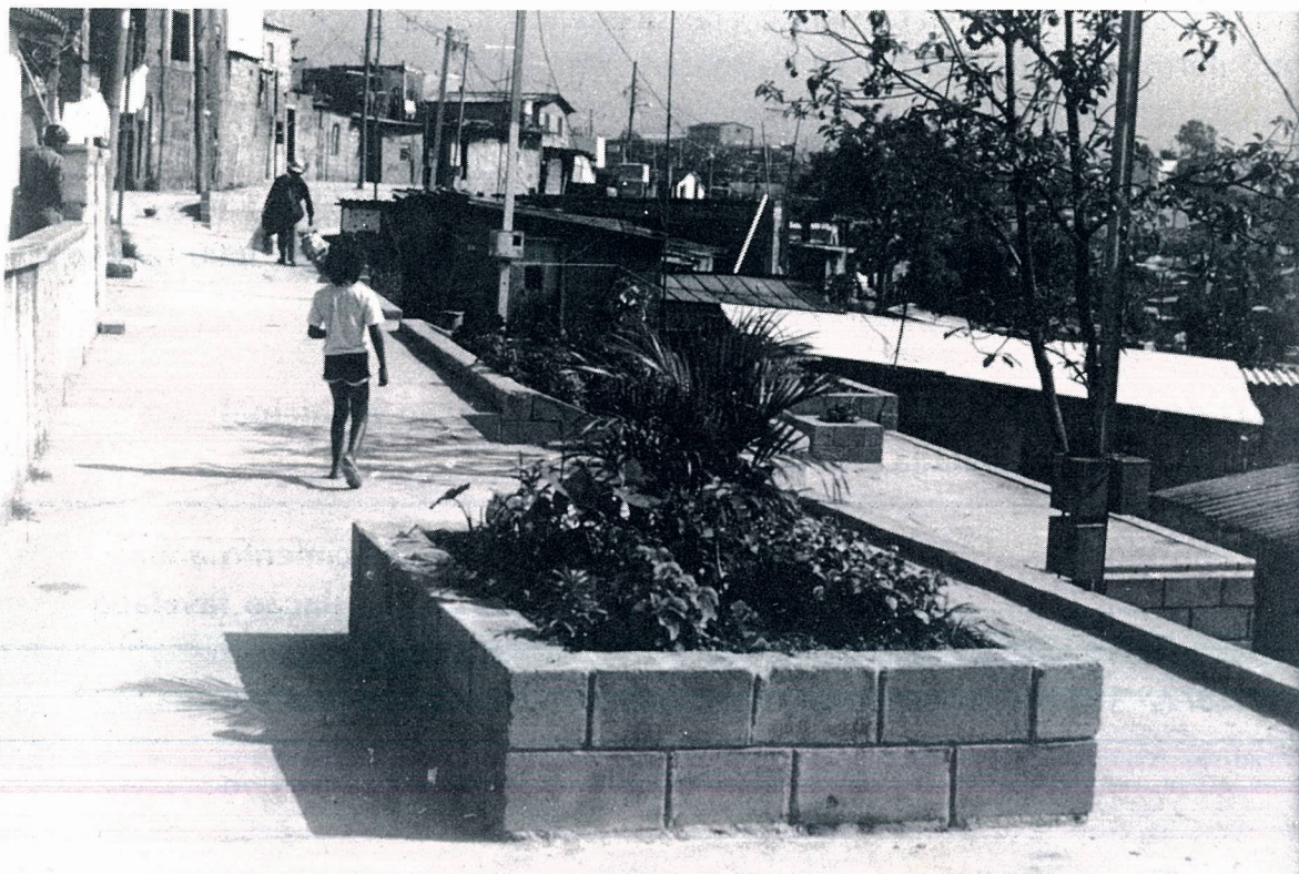
Favela Nossa Senhora Aparecida — São Miguel Paulista (Leste) após a urbanização
