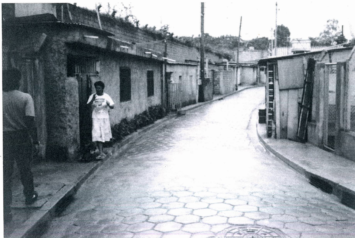
Favela Vila Operária – Butantã (Sul) após as obras de urbanização
